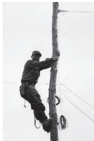
<그림5> 전기 통신선을 가설중인 군노무자, 출처: 폴 팬처 기증 사진
